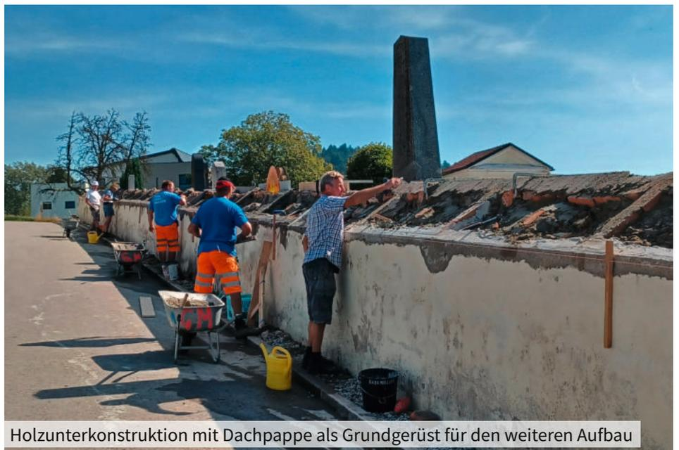
Holzunterkonstruktion mit Dachpappe als Grundgerüst für den weiteren Aufbau
