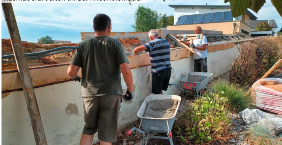
Am 25. September wurde die Firma Krückl beauftragt, die Außen- und Innenmauer fachgerecht zu sanieren. Dazu werden immer zwei Arbeiter von uns zusätzlich benötigt, d.h. dass im Vorfeld unsererseits das lose Mauerwerk/Putz abgeklopft und die Mauer mittels Hochdruckreiniger vom Schmutz befreit wird, um dann diese Arbeiten überhaupt durchführen zu können. Leider stellte sich heraus, dass auf
