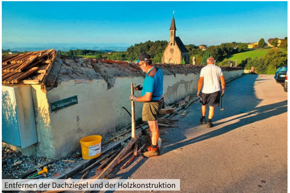
Entfernen der Dachziegel und der Holzkonstruktion
